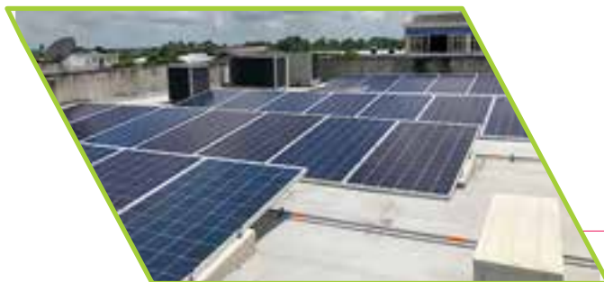
>> Instalación de paneles solares -Sabana de Torres-
